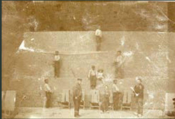
Het vullen van de veldoven, Woerden, Steenfabriek Van Lange ca.1920 (bron: RHC Rijnstreek en Lopikerwaard)
