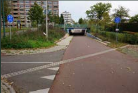
Het tunneltje onder de Utrechtseweg richting Dorpsstraat
