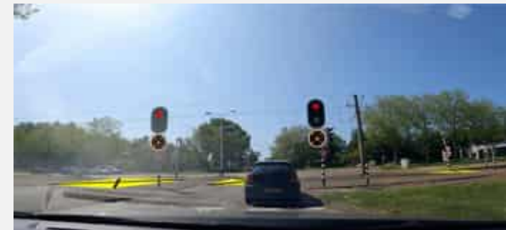
Figuur 24. Richting 4: Plaatsing TWI's voor beide rijbanen.
