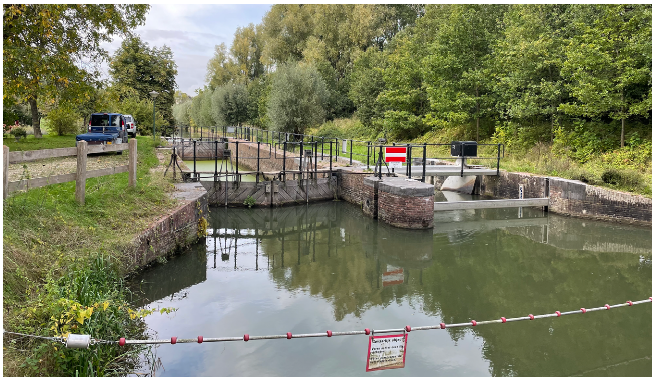
9 Foto schutsluis bij Werkhoven
