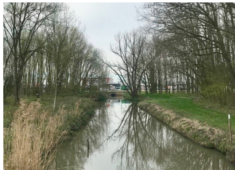
Foto van het brede inundatiekanaal ten zuiden van de Houtenseweg/N409
