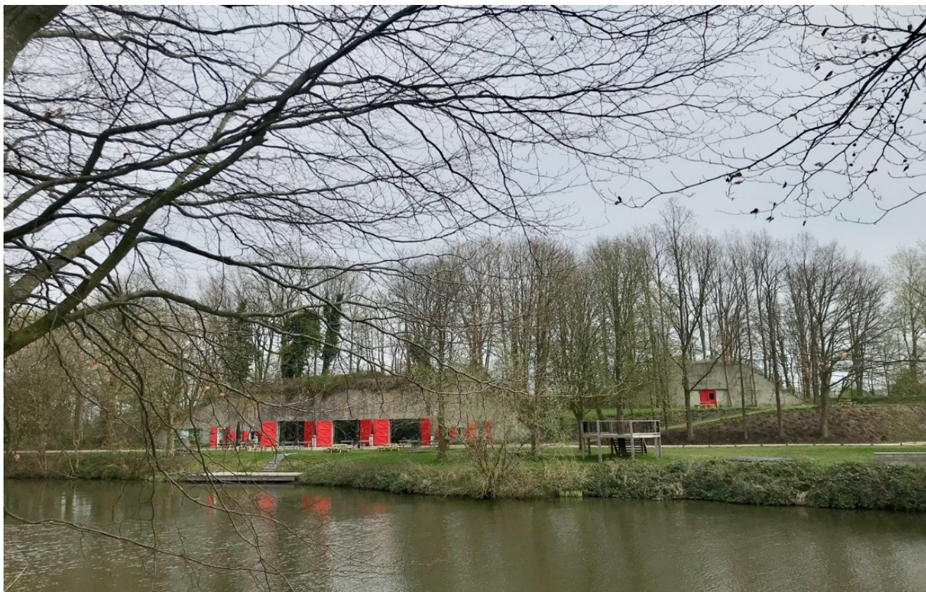
Foto van de batterijen aan de overeindseweg vanaf de inundatiekade (2de veld).
