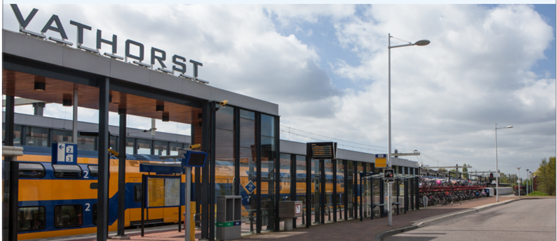
Station Amersfoort Vathorst op de corridor Utrecht-Amersfoort-Nijkerk
