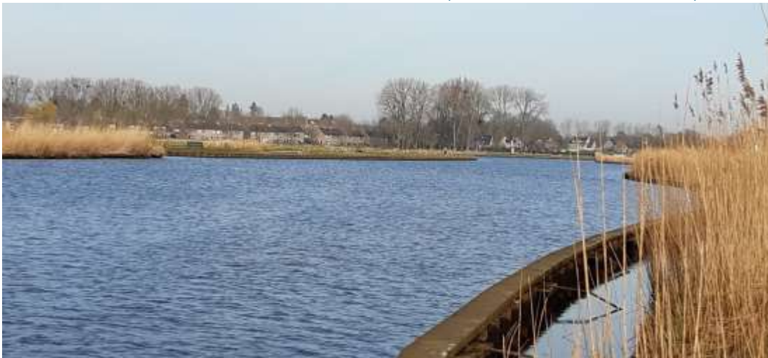
Figuur 12 Plasberm met rietkraag achter een verlaagde damwand.
