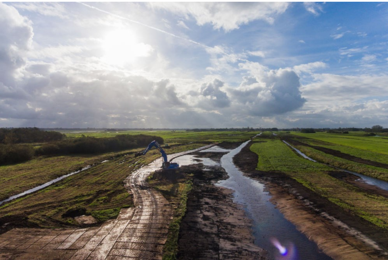
Rijplatenbaan tijdens het afgraven.
