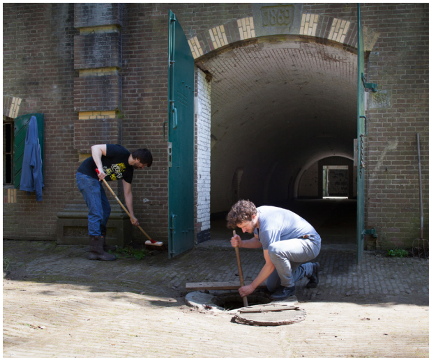
Onderhoudswerkzaamheden door vrijwilligers aan een fort.
