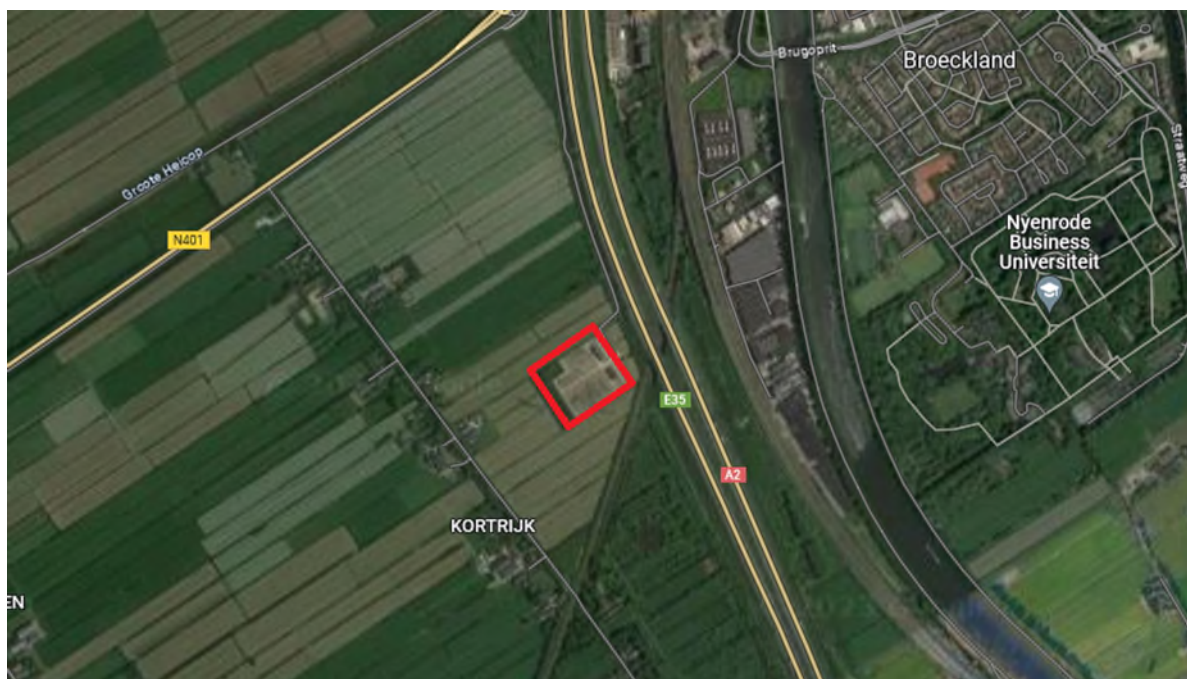
Figuur 1: Locatie van het huidige transformatorstation Breukelen – Kortrijk 380/150 kV
