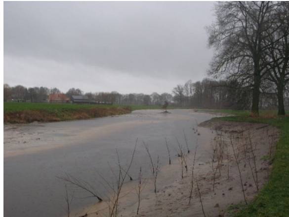
Afbeelding 9 Aanleg natuuroevers Luntersebeek
