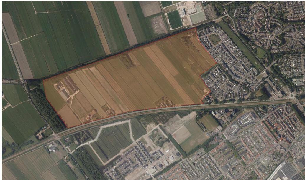
Figuur 2.2 Luchtfoto Broekgraaf Noord
