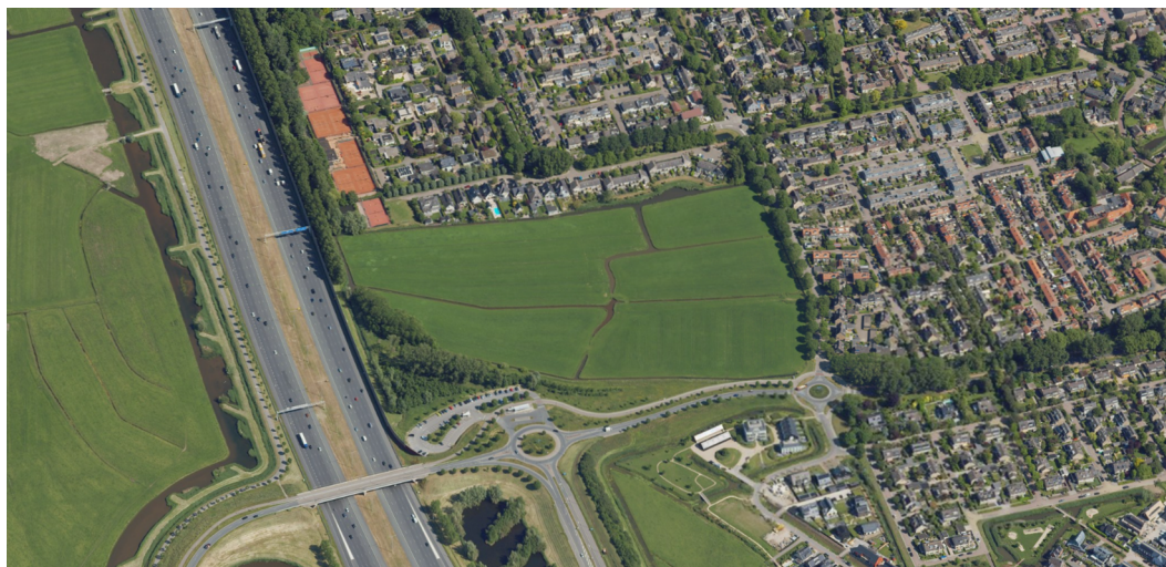
Figuur 8.1: Recent luchtbeeld van de locatie. Het gebied is volledig ingeklemd tussen autosnelweg en verstedelijkt gebied. Van wezenlijke erfgoedwaarden (in relatie tot de Stelling van Amsterdam) is geen sprake.
