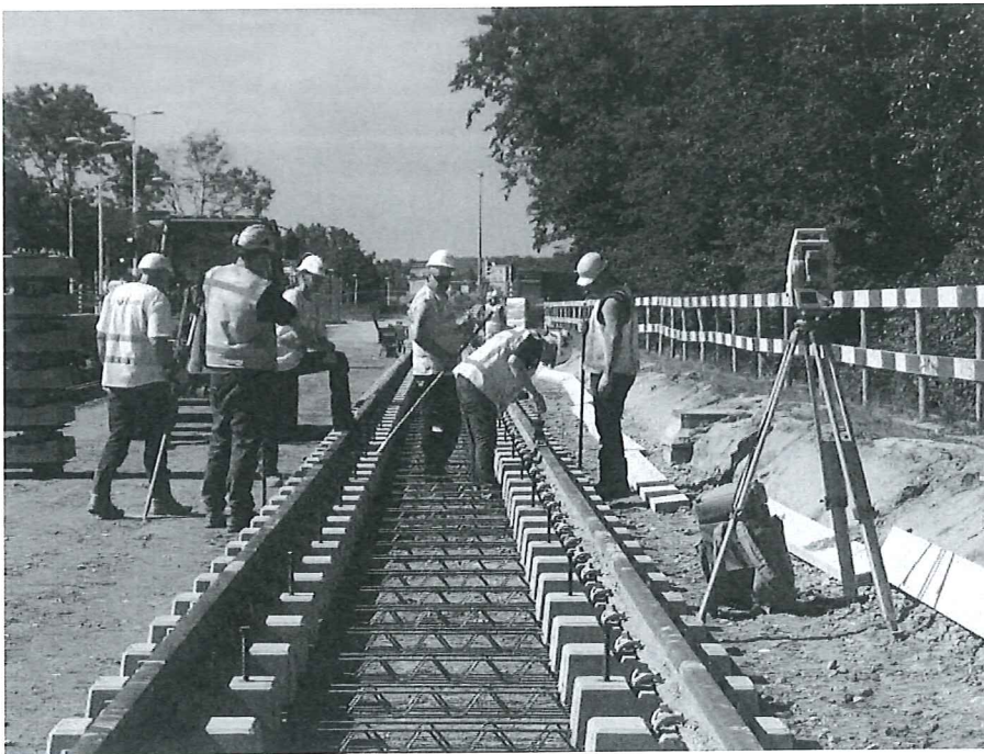
Aanleg spoor aan de Laan van Maarschalkerweerd (foto: E. Warmer)
