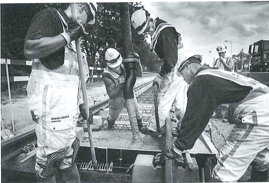
Betonstort (foto: G. Semé)
