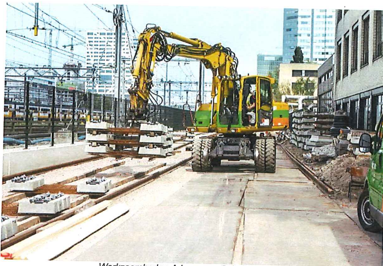
Werkzaamheden Adama van Scheltemabaan
