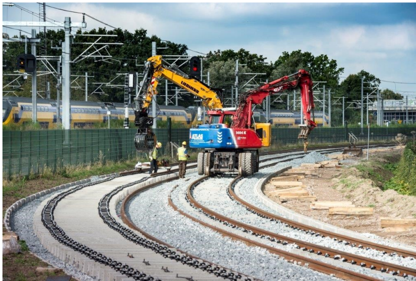
Werkzaamheden naast de spoorlijn Utrecht-Arnhem, ter hoogte van de Laan van Maarschalkerweerd
