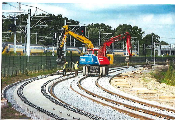
Werkzaamheden naast de spoorlijn Utrecht-Arnhem, ter hoogte van de Laan van Maarschalkerweerd
