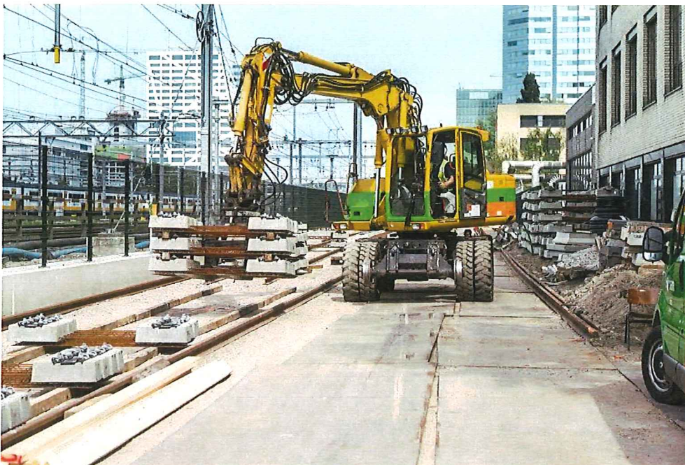
Werkzaamheden Adama van Scheltemabaan
