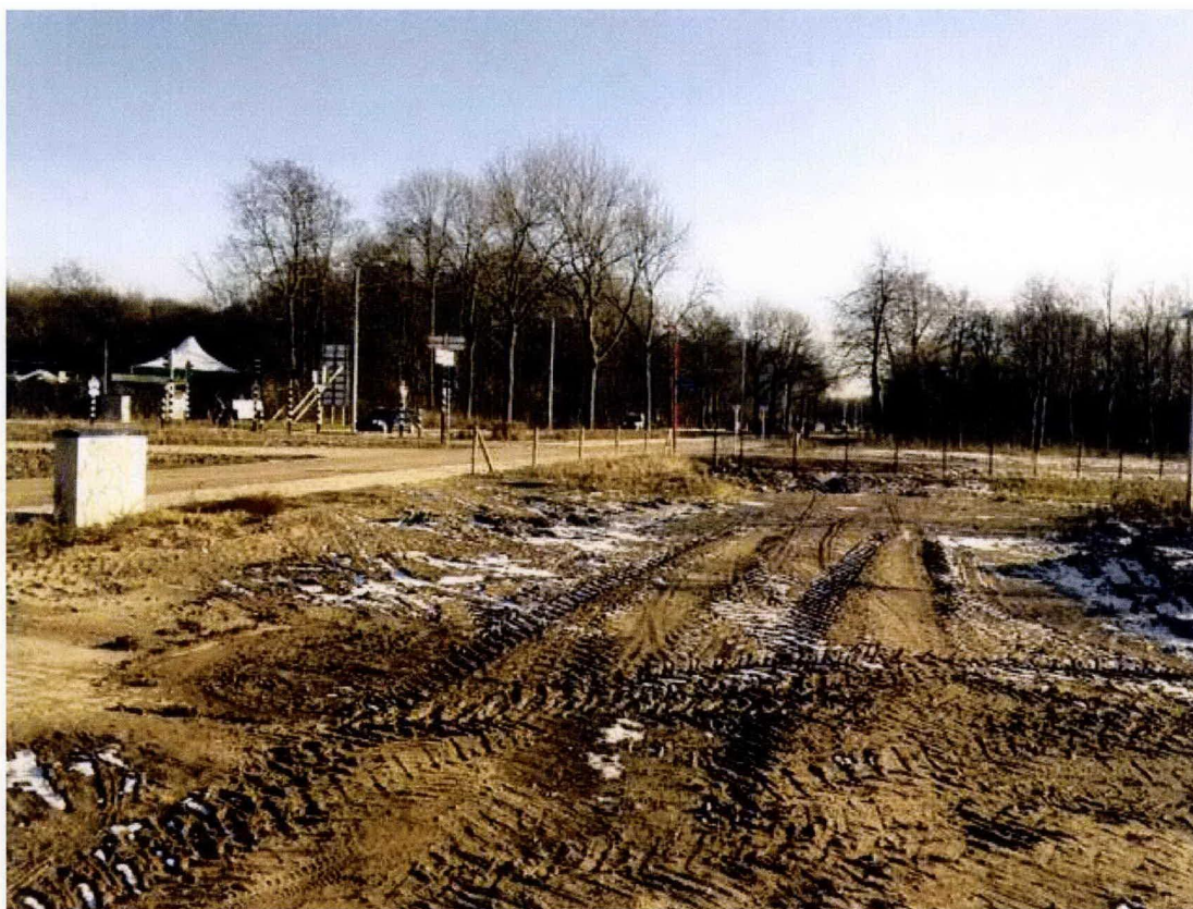
Afbeelding 2: foto van de locatie waar het onderstation gerealiseerd gaat worden.
