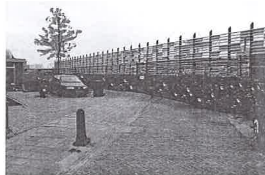
Impressie keermuur met dubbelstaafmat hekwerk en geluidwerende vluchtdeur. Muur beplant met Klimhortensia en Klimop.
