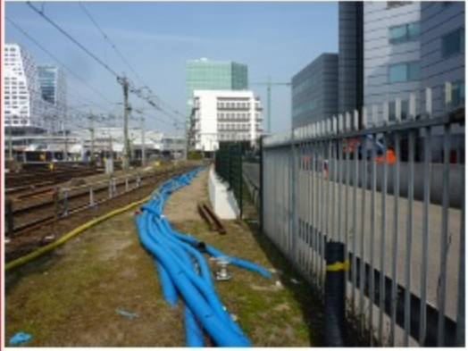
Overgang barrier naar spijlenhekwerk
