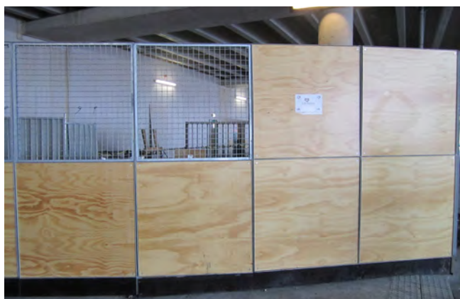
1. Voorbeeld van een arauco-paneel, gefreesd en tweezijdig gelakt. Daarboven een verzinkt gaasframe.
