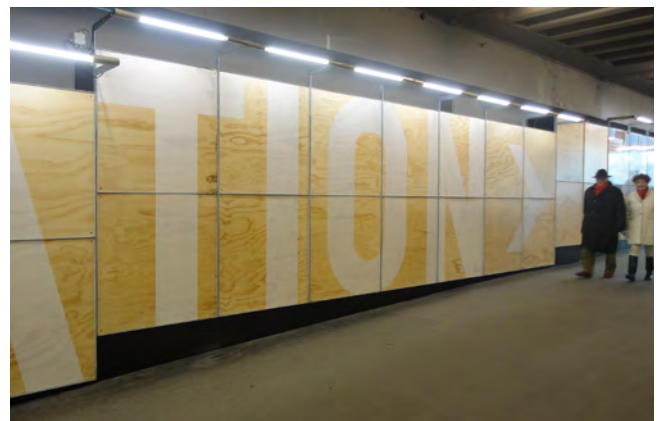
5. Toepassing van TL-verlichting met kabelgoot, Utrecht Centraal Station.
