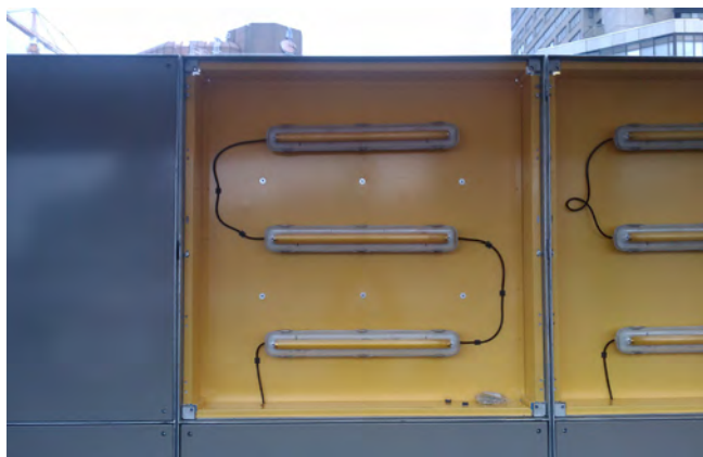
4. Voorzijde van een lichtbak, zonder paneel, Utrecht Centraal Station.
