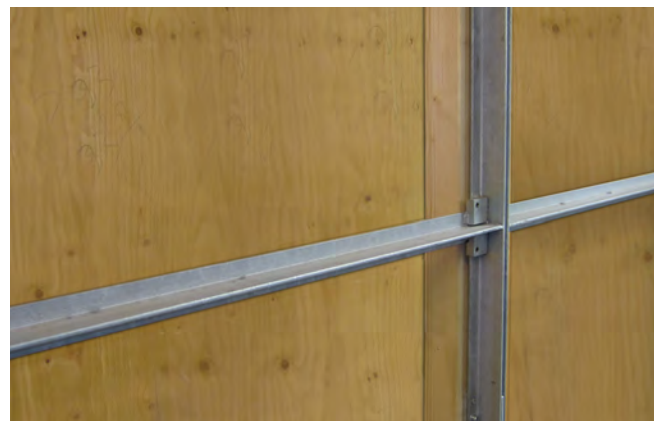
5. Detail van een houten stijl tegen een underlayment wand.
