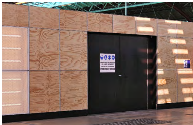
FACILITAIR LAAG | toegangsdeur in nis
