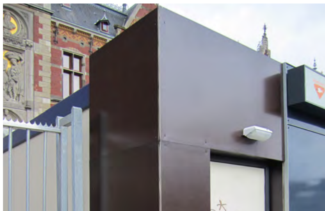
1. Betonplex passtuk, Amsterdam Centraal Station.
