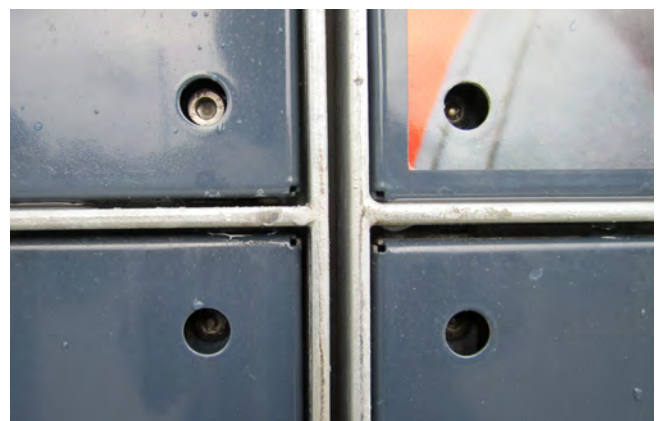
5. Detail van een gepoedercoat zinc paneel, deel voorzien van een grafische laag (in dit geval een foto).
