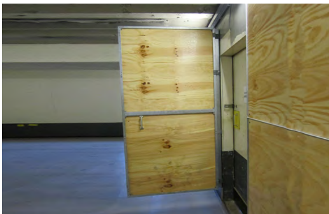
3. Toepassing van een deur in een frame, ten behoeve van een doorgang op Amsterdam Centraal.
