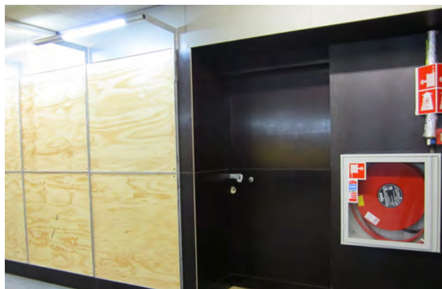
2. Betonplex passtuk, Amsterdam Centraal Station.
