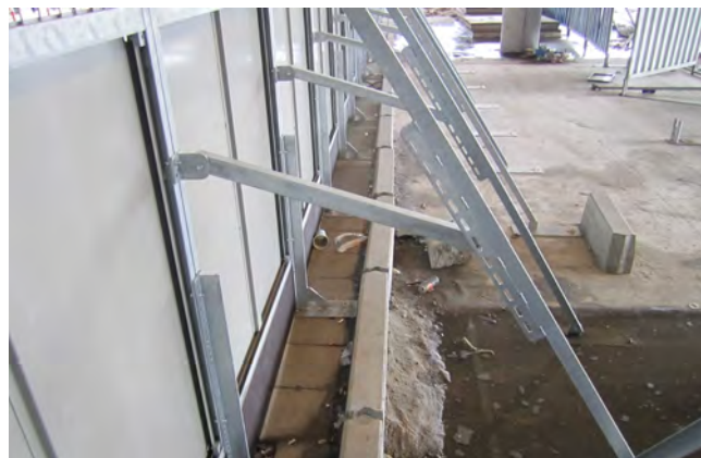
3. Toepassing op ongelijke vloer. Amsterdam Centraal Station.
