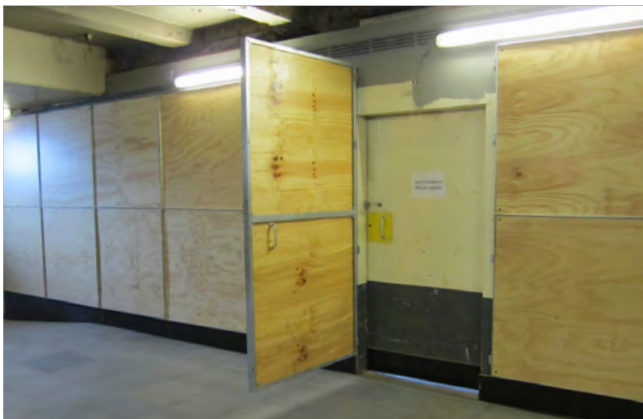
1. Toepassing van een deur in een frame, ten behoeve van een doorgang op Amsterdam Centraal.
