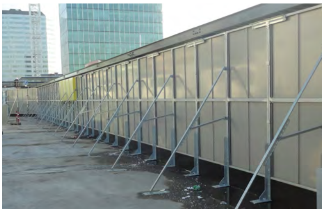
4. Vrijstaande wand geschoord op Utrecht Centraal Station.
